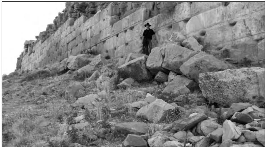
Abb. 23 - Die Frontmauer aus nächster Nähe mit Marco als Größenvergleich: Hier lässt sich der vertikal schichtweise Aufbau der Mauer erkennen: bearbeitetes Abdeckmauerwerk mit dahinterliegendem Rohmauerwerk. Die Mulden zwischen den Steinen repräsentieren die Ausschlaglöcher, in denen die Metallklammern saßen. Interessanterweise wurden diese hier frontseitig angebracht, also nicht gerade feindessicher.
